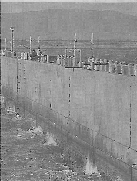
高潮防波堤に高さ上げされる名古屋港防波堤＝愛知県知多市で
